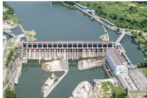
新郷発電所(福島県喜多方市) (※2)
